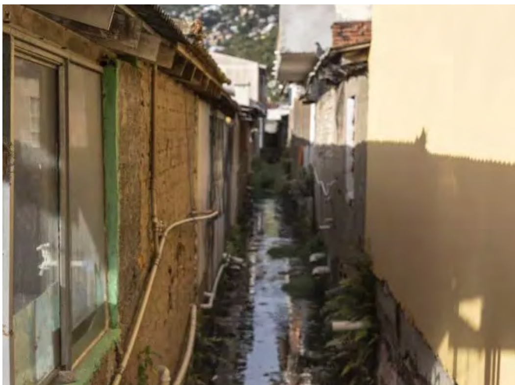
Esgoto a céu aberto. Florianópolis, Santa Catarina.
