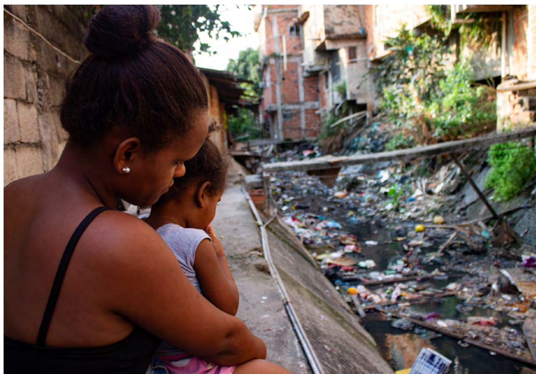
Esgoto a céu aberto no Complexo do Alemão, no Rio de Janeiro.
