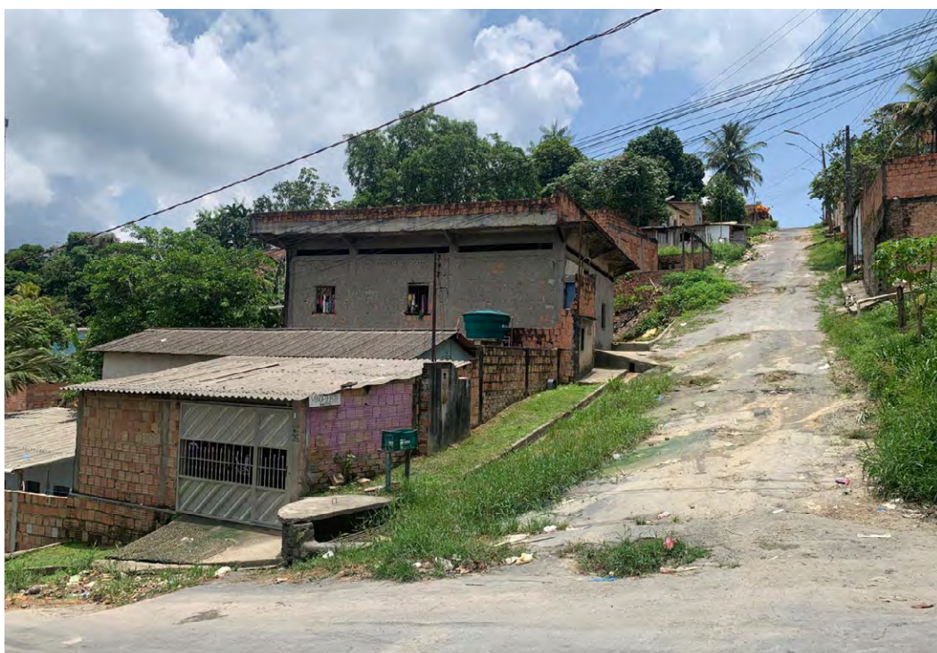
Problemas de Infraestrutura.
